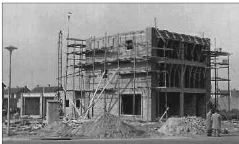
De winkel van Vossen aan de Marisstraat in aanbouw in 1962.
